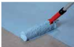
1st coat on screed 第一层涂漆于找平面上
