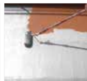
1st layer primer application 第一层涂漆
