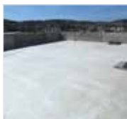
Substrate preparation 准备施用的表面
