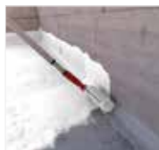
1st layer primer application 第一层涂漆
