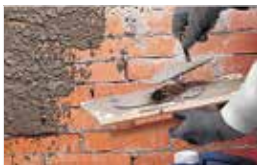
Scratch-coat mortar admixed with MapeLatex 刮涂层砂浆与 MapeLatex 混合使用
