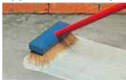
Application of cement-based bonding slurry admixed with MapeLatex 水泥基粘结砂浆与 MapeLatex 混合使用
